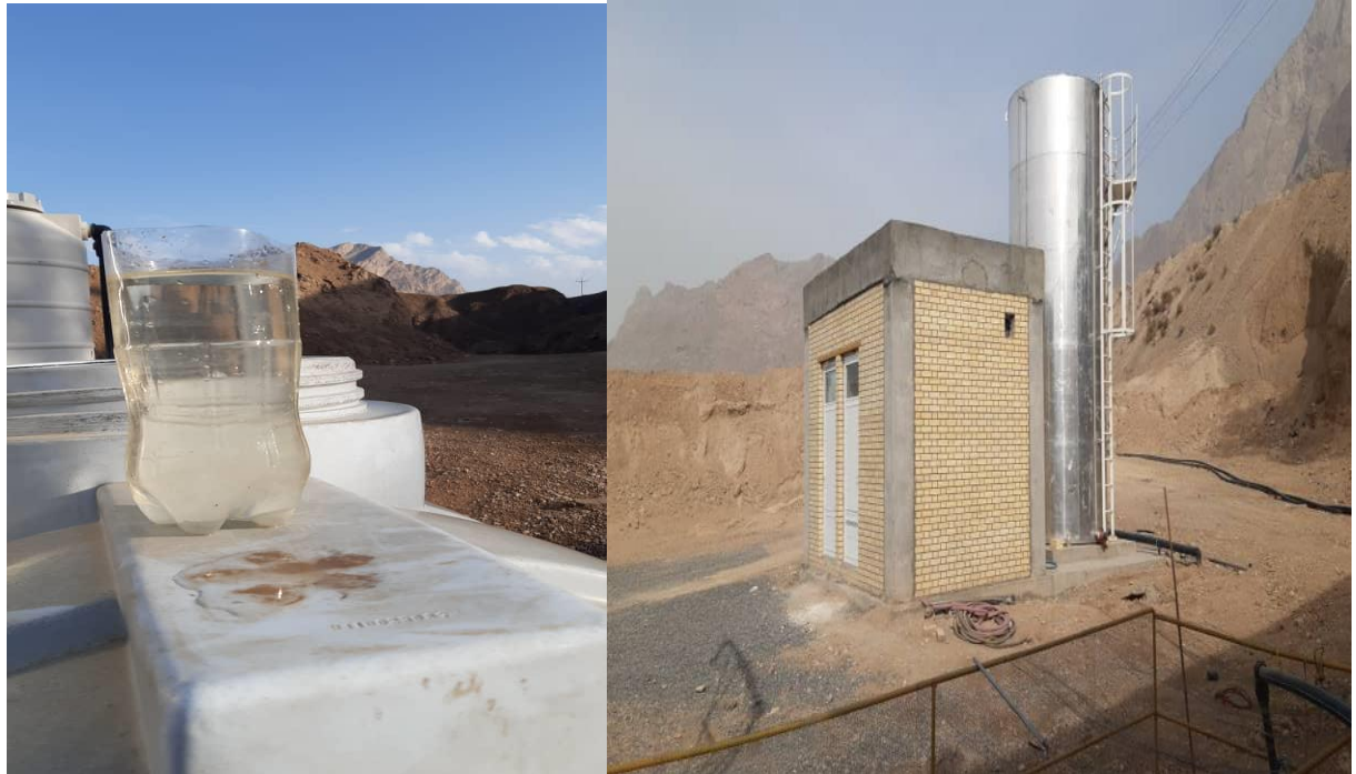
سیستم تصفیه فاضلاب به همراه نمونه خروجی پساب
