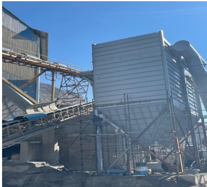
ساخت و اجرا بگ فیلتر
