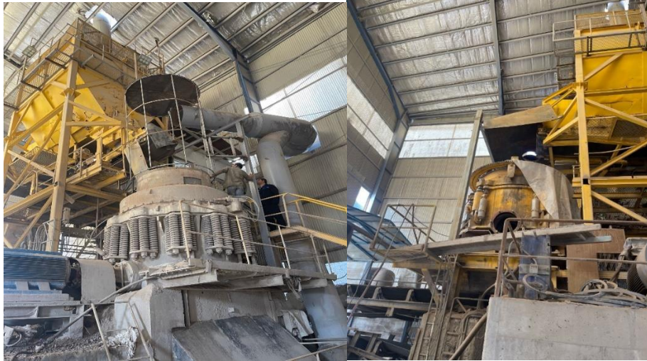
ساخت و نصب هود
