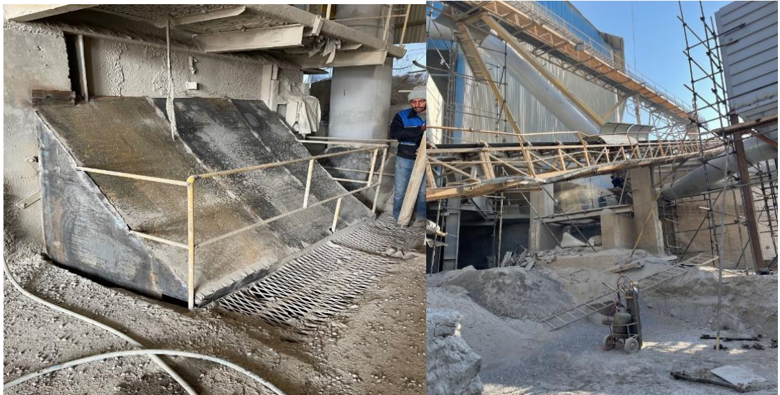
نصب داکتینگ ها و هود ها
