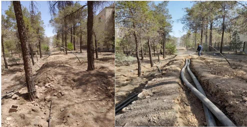
مدفون شدن لوله ها جهت جلوگیری از جوندگی
