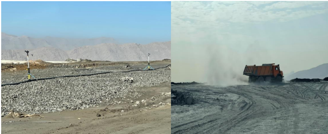
نصب آبیاش روی سد باطله
