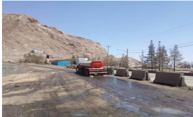
پاشش محلول ssr400 در جاده سنگ شکن
