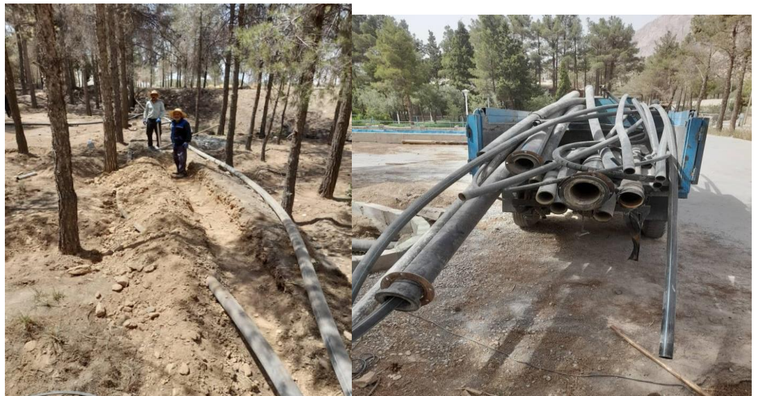
جمع آوری لوله های اضافی و اصلاح مسیر لوله های اصلی
