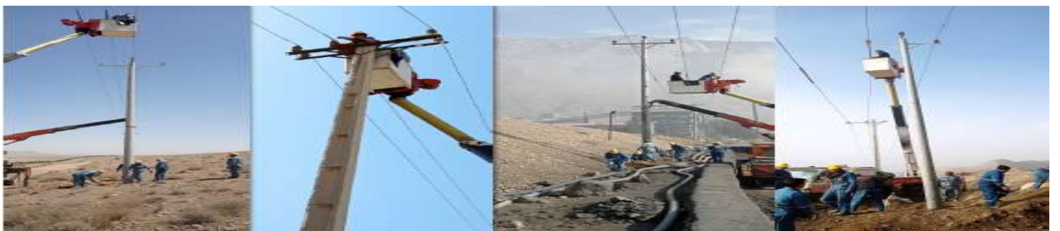
تعمیر تیرهای برق فرسوده
