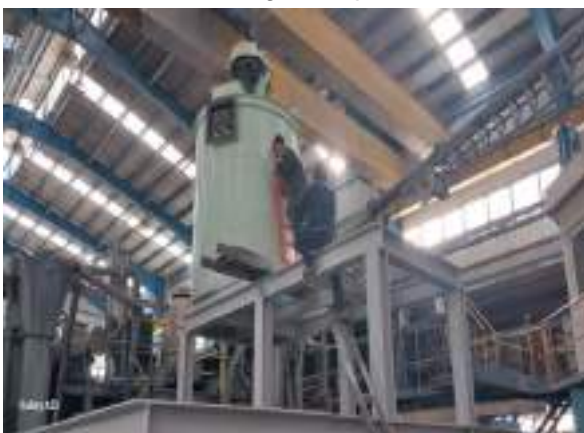
نصب کاندیشنر و سلول ۱۰ متر مکعبی برای کارخانه ۳
