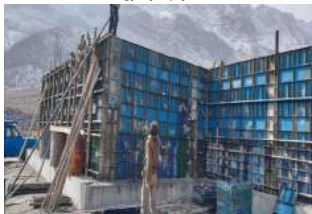
ساخت و راه اندازی استخر بتنی برای تامین آب کارخانه ۳
