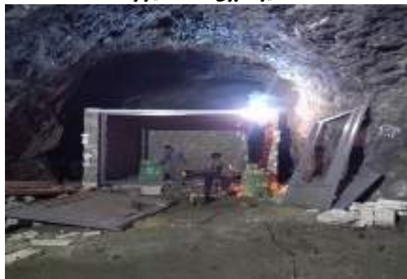
سرویس و نگهداری پست معدن کلاه دروازه
